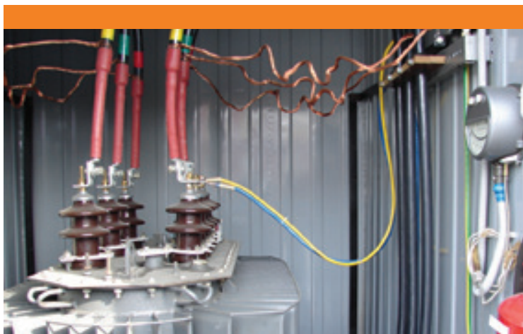
Рис. 10. Специализированный трансформатор для питания скин-системы обогрева на Заполярном НГКМ
