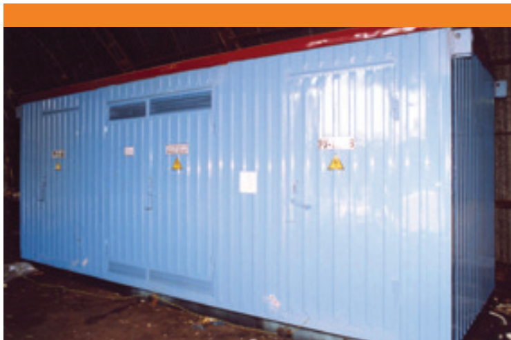
Рис. 11. Внешний вид КТП для питания скин-системы обогрева
